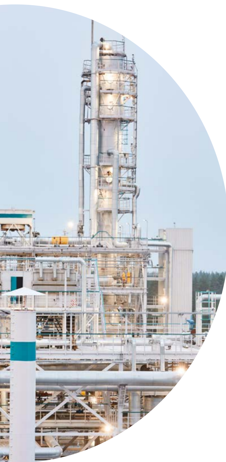
ПАО Сибурхолдинг (СибурТюменьГаз. Вынгапуровский ГПЗ)
