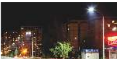
Модернизация сетей наружного освещения г. Челябинска, МБУ «ЭВИС», 2020-2021гг.
