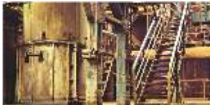
Освещение производственных площадей и прилегающих территорий ПАО «Магнитогорский металлургический комбинат», 2011-2021 г.
