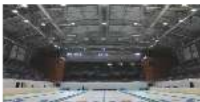
Освещение многофункциональной арены «Ледяной куб», г. Сочи, 2017 г.
