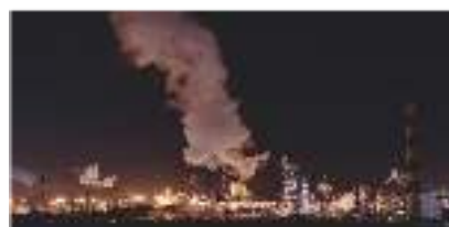
Освещение нефтехимического комплекса ООО «Газпром нефтехим Салават», Республика Башкортостан, 2019 г.
