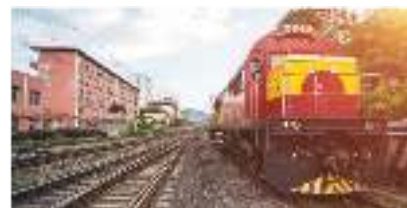
Освещение железнодорожной станции «Тамань-Пассажирская», г. Тамань, 2019 г.
