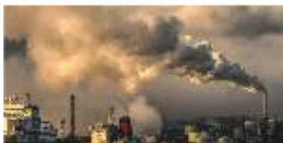
Освещение цехов ОАО «Лебединский ГОК» (Холдинг «Металлоинвест»), г. Губкин, 2019 г.
