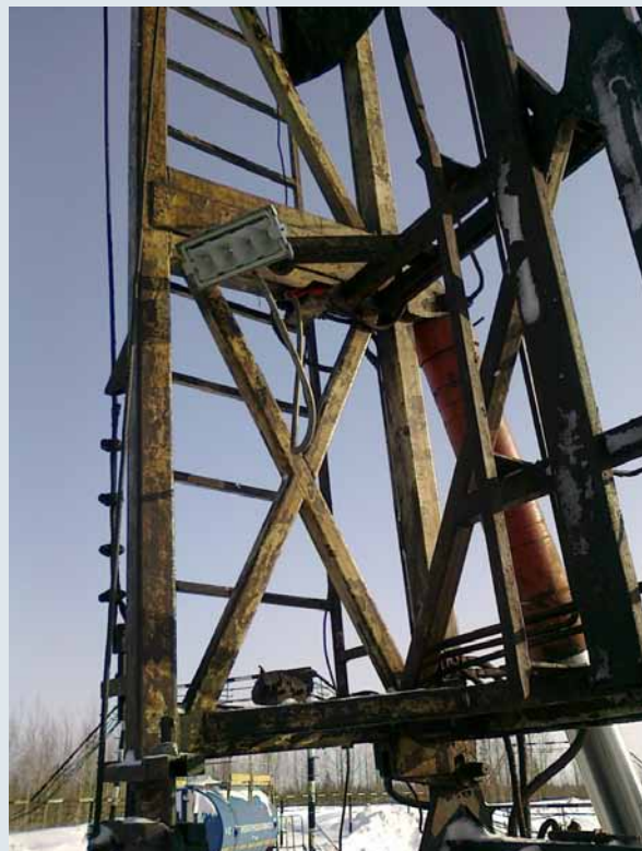
ССП01-4, ООО Черногорнефтесервис
